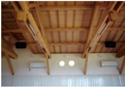
天井は釘を使わず昔ながらの工法で組まれています
