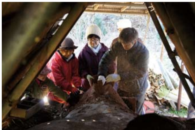
土の壁を崩していきます。
